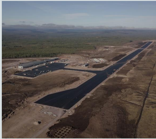
Oktober 2018 Asfaltering av fullstor landningsbana
